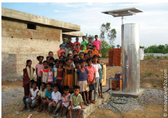
Tal vez lo más importante sea su rápida instalación en cualquier lugar, siempre que haya una fuente de agua como un río o un pozo cercano. Gracias a los paneles solares incorporados y a una turbina de viento opcional, el sistema no necesita fuente de alimentación.
